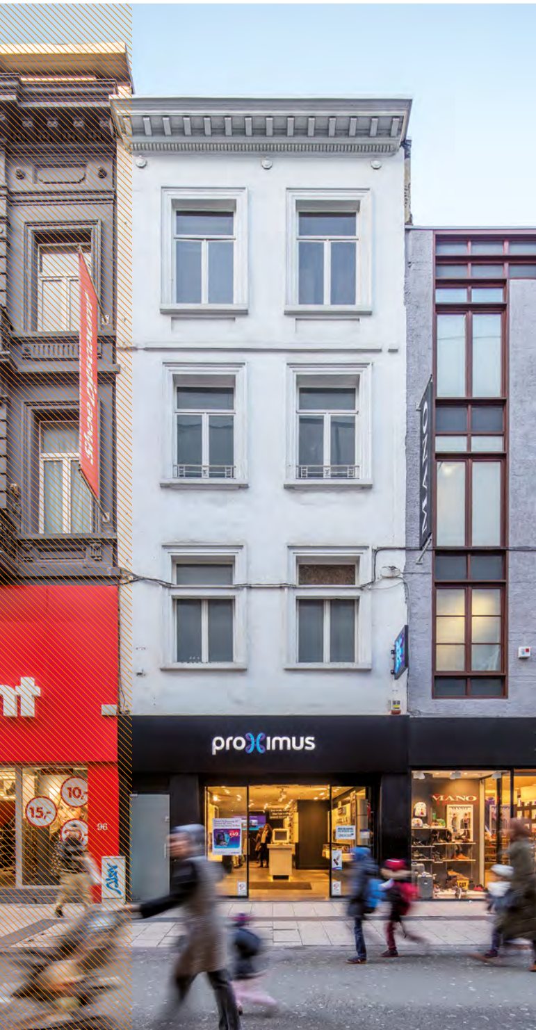
Brussel - Nieuwstraat - Proximus
